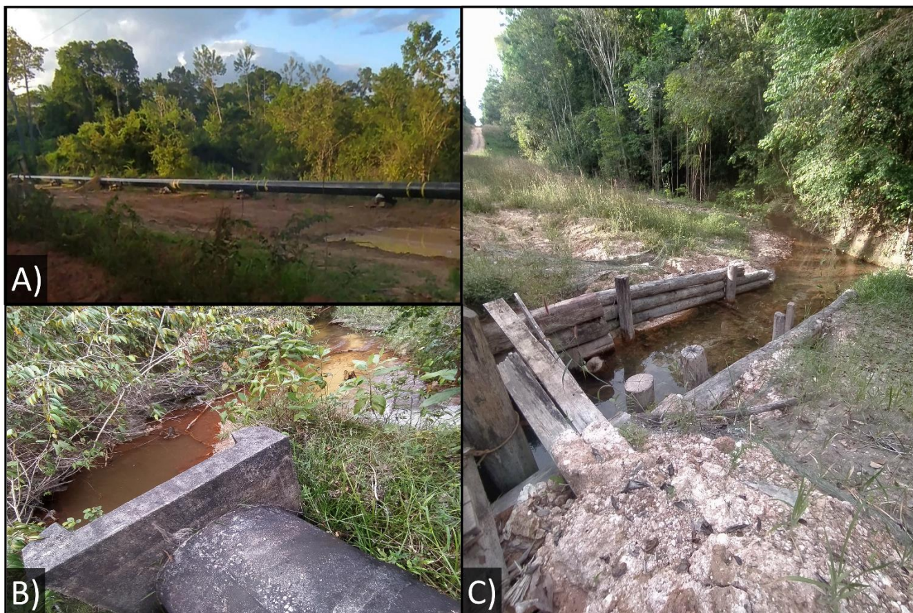
Figura 2. A) Mineroduto transportador de bauxita em processo de instalação e em sua lateral, a estrada de acesso. Tubos de 12 m de comprimento e 20” de diâmetro são interconectados e enterrados. B) Manilhas de concreto ou C) galerias de madeira que são frequentemente utilizadas como meio de transposição da água pelas estradas e pontes de acesso ao mineroduto.
