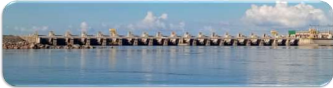
Figura 1: Vista Frontal da Usina Hidrelétrica Belo Monte, Sítio Pimental, Rio Xingu, Altamira, Pará.
